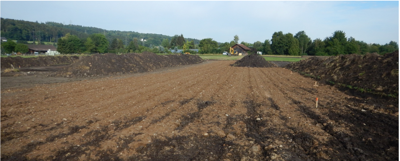
Bodenauftrag Etappe 1 (Bild: FRIEDLIPARTNER AG)
