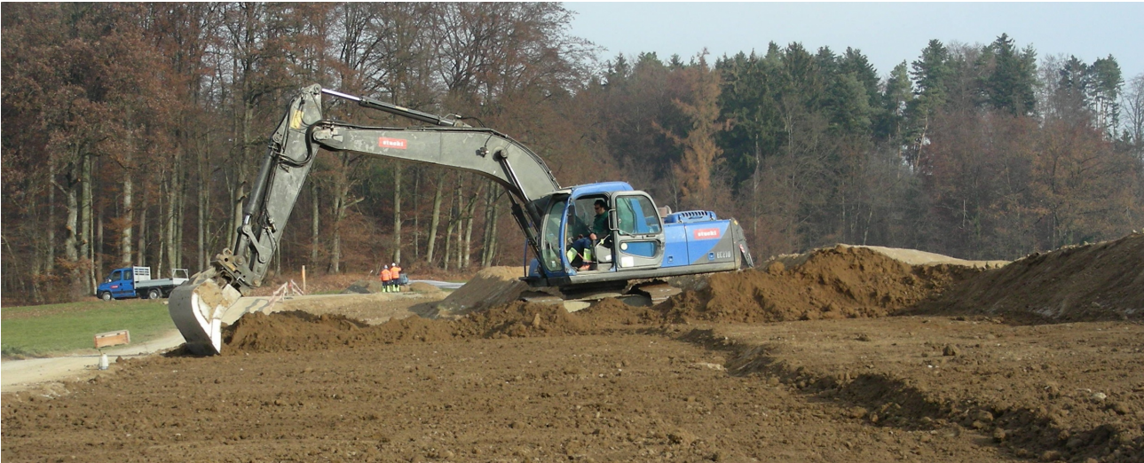
Wiederherstellung Leitungstrasse (Bild: FRIEDLIPARTNER AG)
