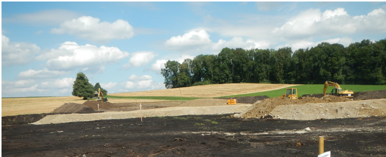
Bodenauftrag Etappe 1 (Bild: FRIEDLIPARTNER AG)
