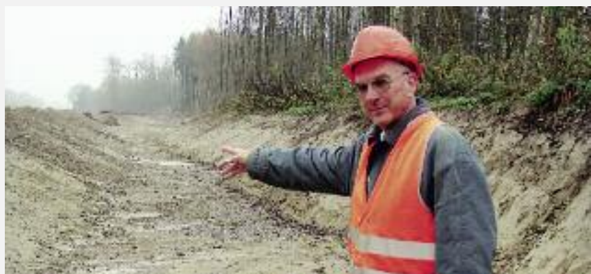
«Eine BBB lohnt sich auch für den Bauherrn. Eine Totalsanierung kommt viel teurer», sagt Werner Rohr.
