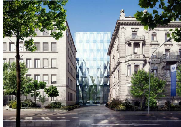
Zürich Versicherungs-Gesellschaft, Um-/Neubau „Quai Zurich“
