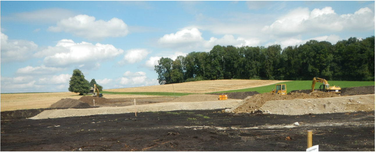
Bodenauftrag Etappe 1 (Bild: FRIEDLIPARTNER AG)
